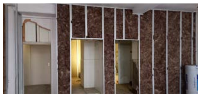
En cours d'isolation
