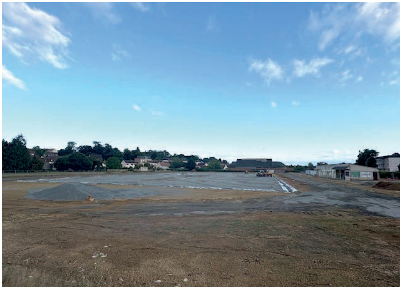
Drainage en cours
